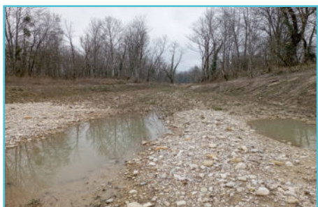
Chenal d'expansion de crue (Varambon)
