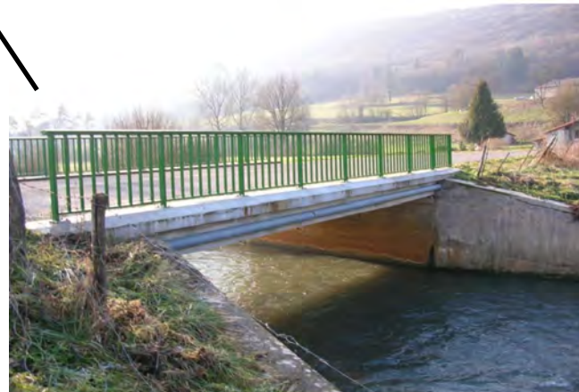
Fig.3: Pont de la route départementale RD190
