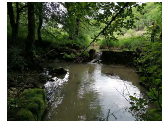
Vue du seuil aval dont la présence a permis l'installation d'une zone humide
