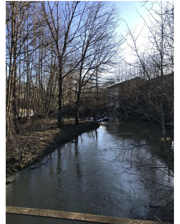
Seuil de Chavuisiat (réserve incendie, absence d'entretien de l'ouvrage, parcours de pêche no-kill)
