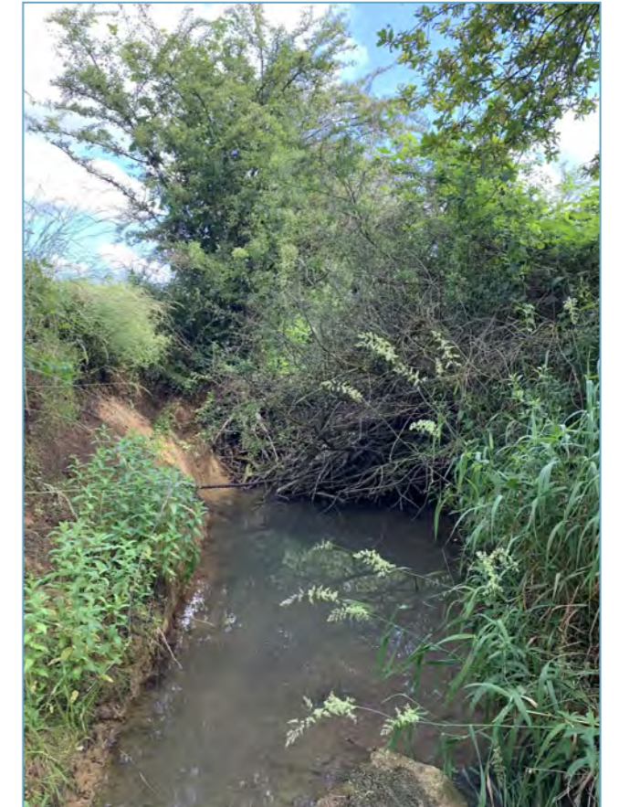
Berges actuellement raides sur le ruisseau de Sous-Roche
