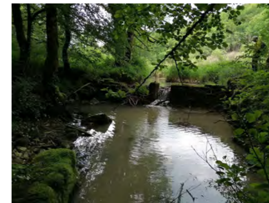
Vue du seuil aval dont la présence a permis l'installation d'une zone humide
