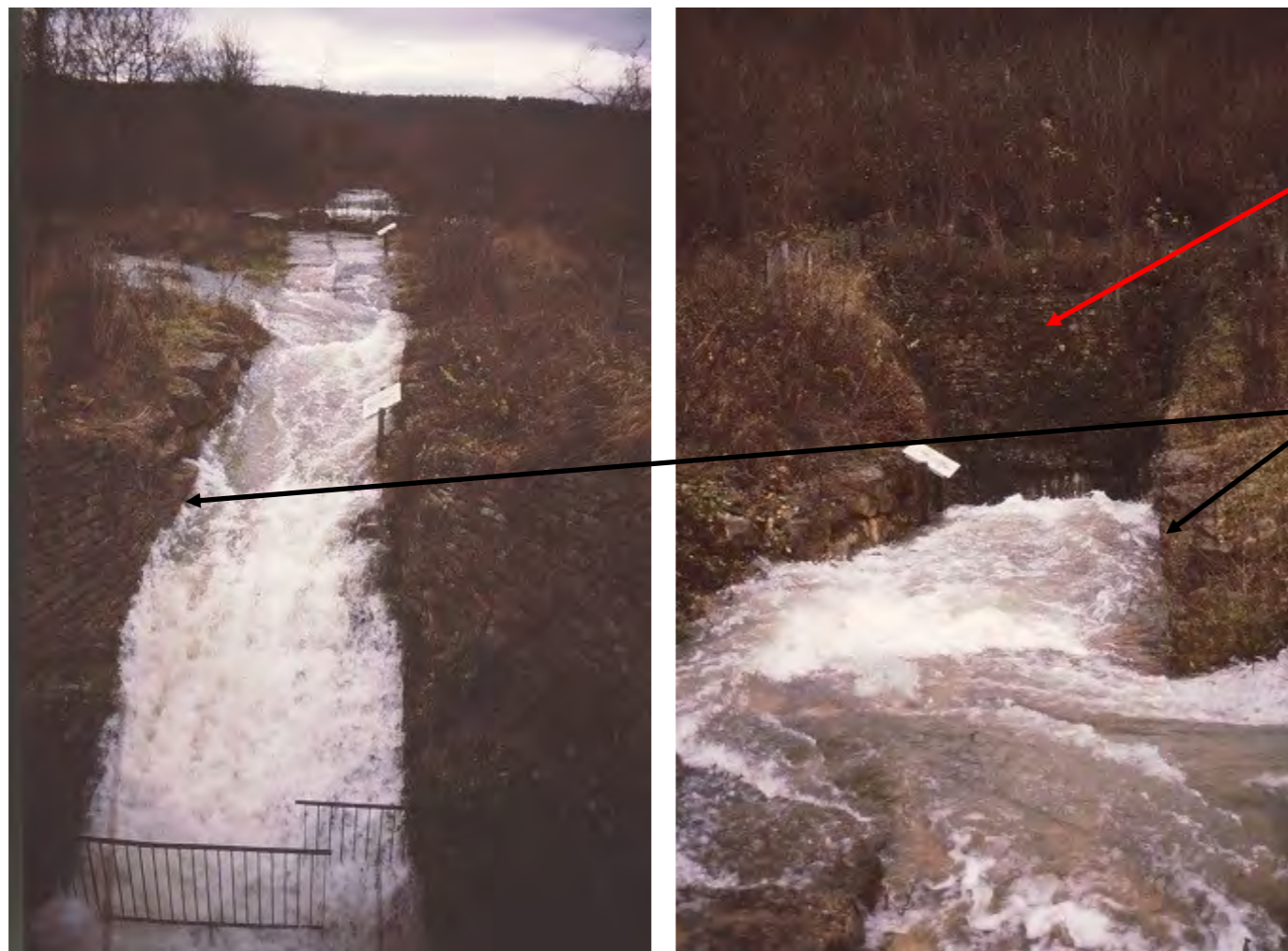
Fig.4: Entrée du tunnel en eau, novembre 2002 (source : Dromoscope)
