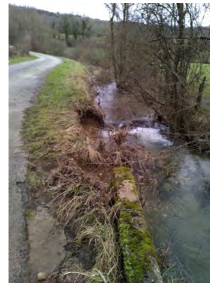
Vues du pont du Goulet et du Ponson
