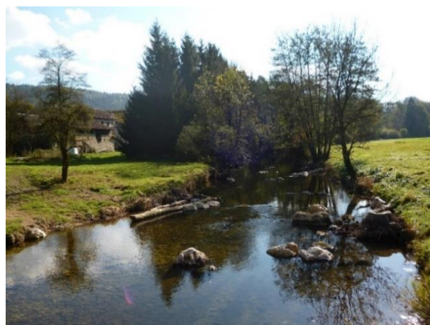
Exemple de mise en place d’éléments de rugosité sur l’Oignin à St Martin du Frêne
