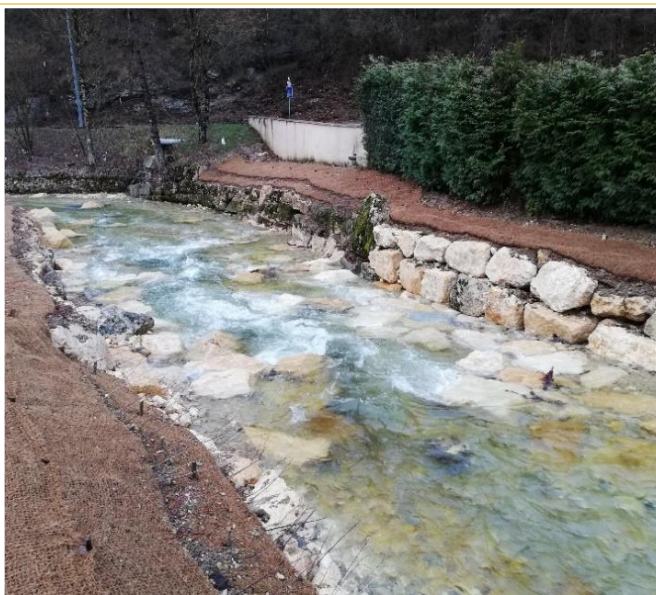
Rampe en enrochements du Lange à Geilles (Oyonnax)
