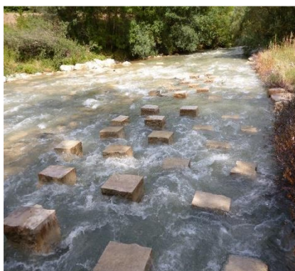
Passé à poissons sur l’Oignin à Saint Martin du Frêne
