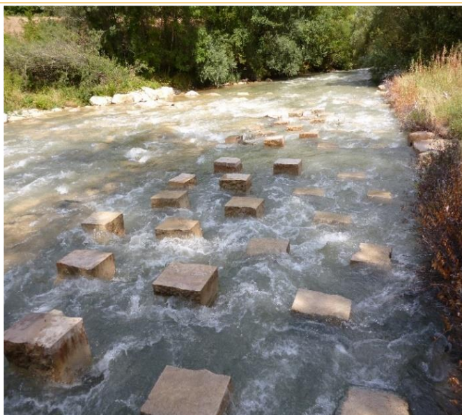
Passé à poissons sur l’Oignin à St Martin du Frêne
