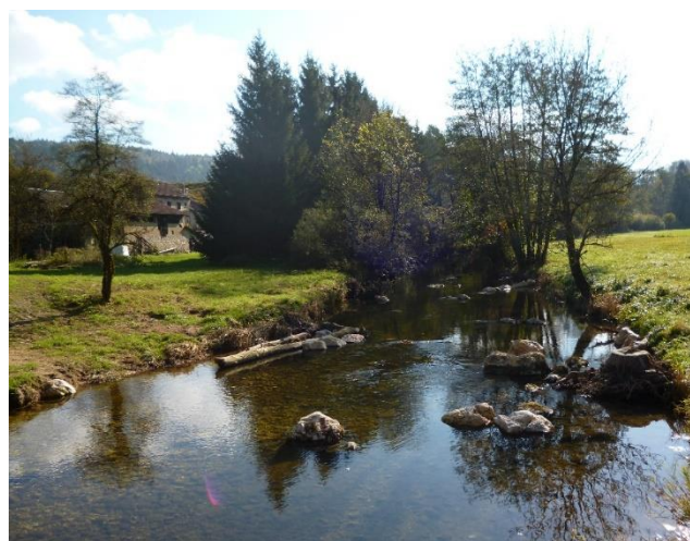
Etat après travaux
