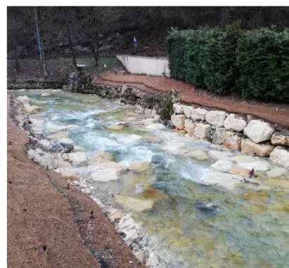
Rampe en enrochements sur le Lange à Geilles
